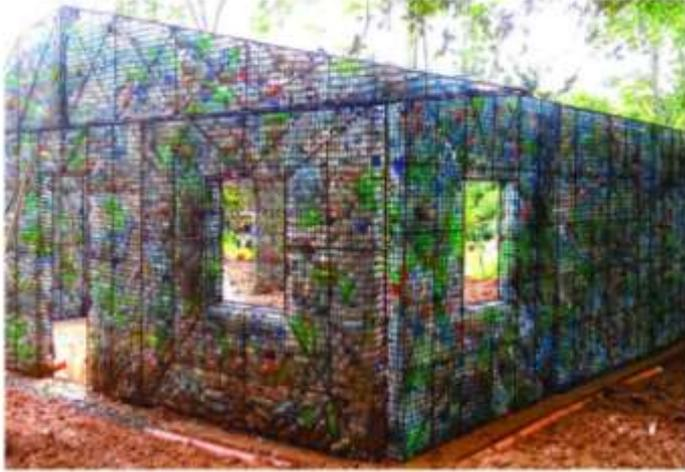
Gambar 2. Kerangka bangunan dari botol plastik
